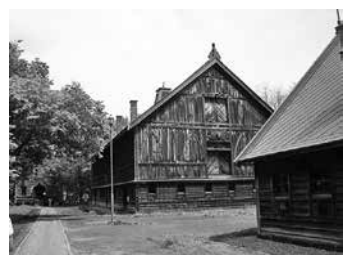
写真2 札幌農学校第2農場のモデルバーン(模範家畜房) 1階が家畜房で2階及び3階が乾草庫(近藤写)
