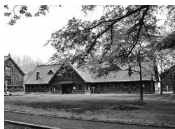
写真3 札幌農学校第2農場の牧牛舎 1階の向かって左側が育成牛ストール、右側が搾乳牛ストール。 2階は乾草庫(近藤写)
